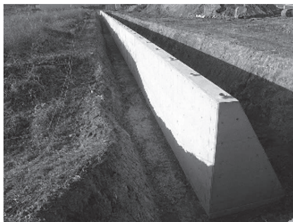
▲重力式擁壁設置
